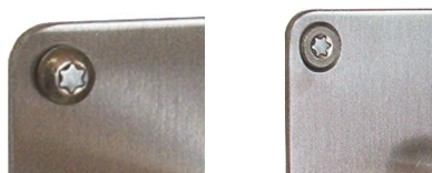
Detail hier Linsen- und Senkschraube mit Einpressstern
